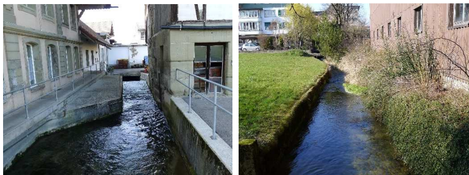
Abb. 5) Kanalsystem Burgdorf (Fotos: georegio ag)
